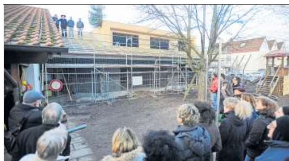
Der Tradition gemäß hat Zimmermann Martin Bechle sein Glas auf dem frisch errichteten Dach zertrümmert.
